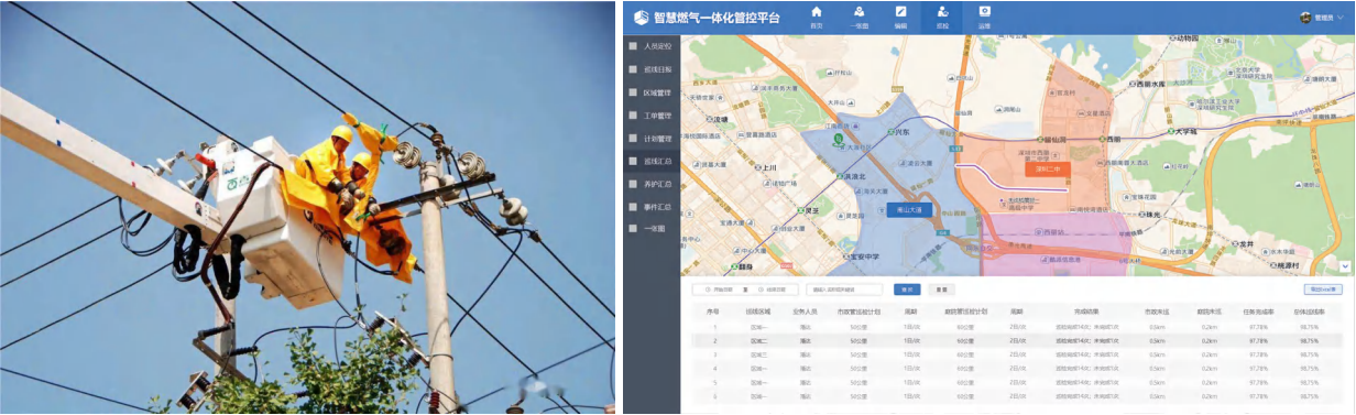
带电安全检修作业
